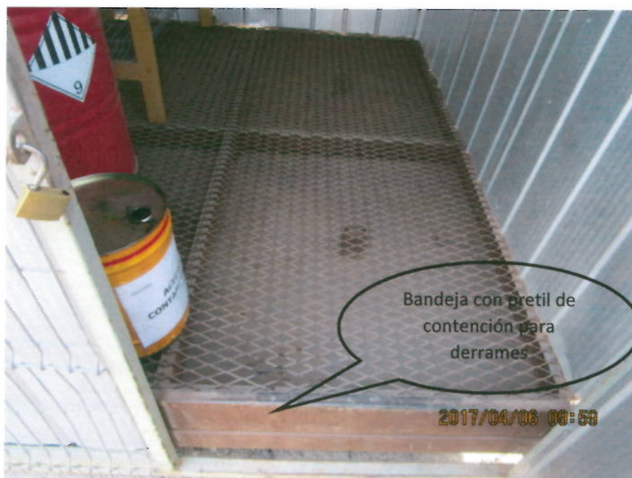
Foto 5: Bandeja con pretil para contención de derrames en BAT Bocatoma-
